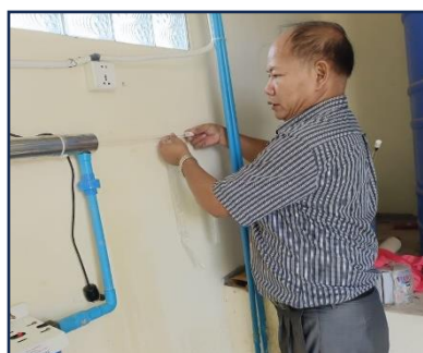
La pose de l'installation de traitement d'eau avec Ngoy
