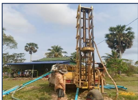
Le forage pour atteindre la nappe phréatique
